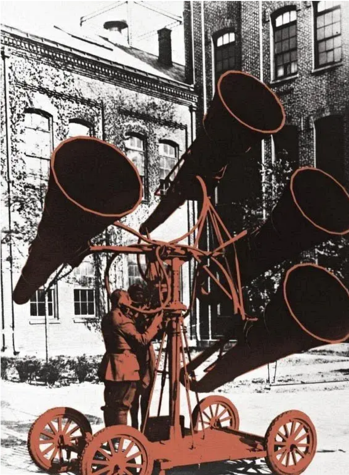
Vorläufer des Radars: Mit solchen riesigen Hörrohren spürt die deutsche Luftabwehr gegnerische Flugzeuge auf (1914)
